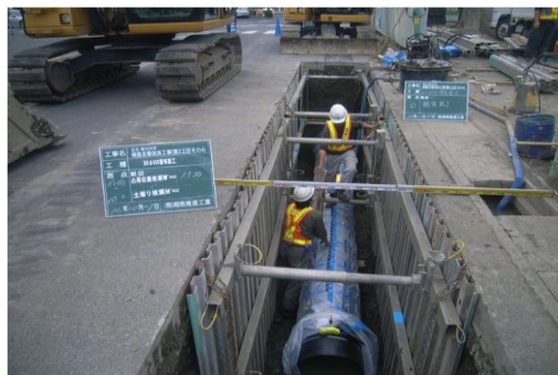
【老朽管更新工事（県営水道）】
