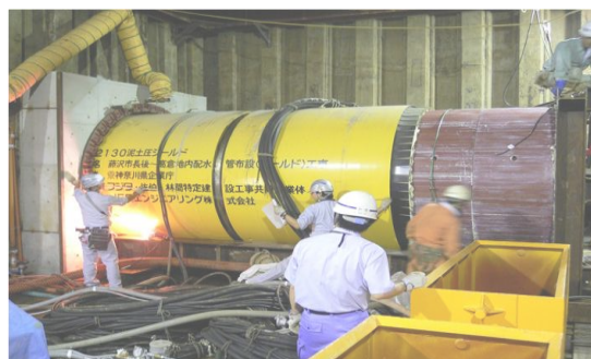
【連絡管シールド工事（県営水道）】
