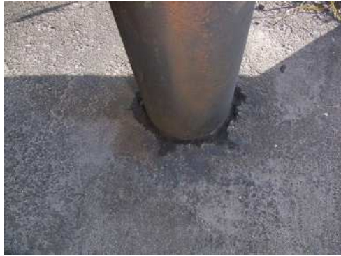
腐食、路面付近での滞水
