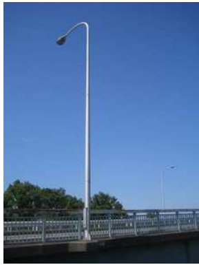
橋梁部に設置
