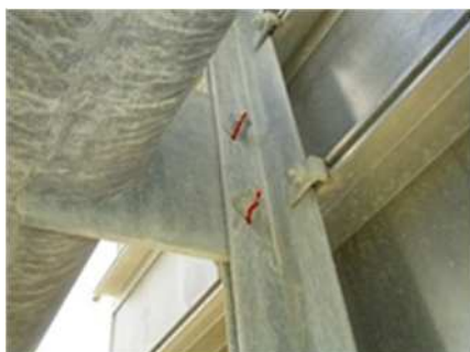
標識板取付部
