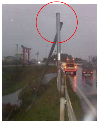
写真-解 8-8 支柱継手部の折損状況
