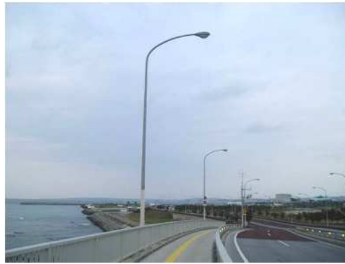
海岸付近に設置
