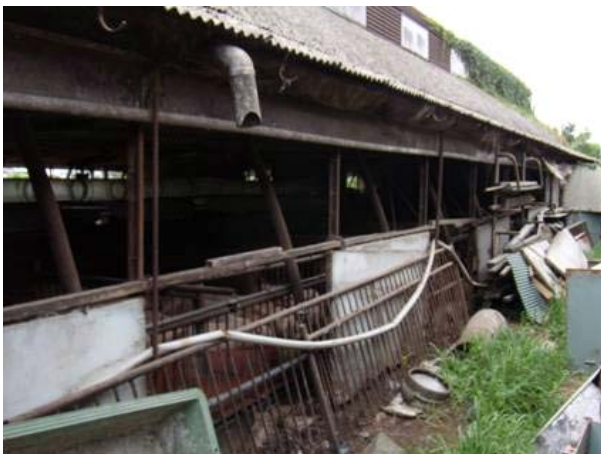
写真4 豚舎壁の一部撤去
