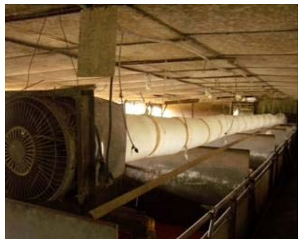
写真5 送風ダクトの設置
