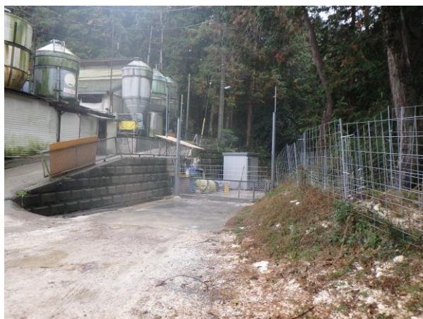
写真3 いのしし防護柵の設置
