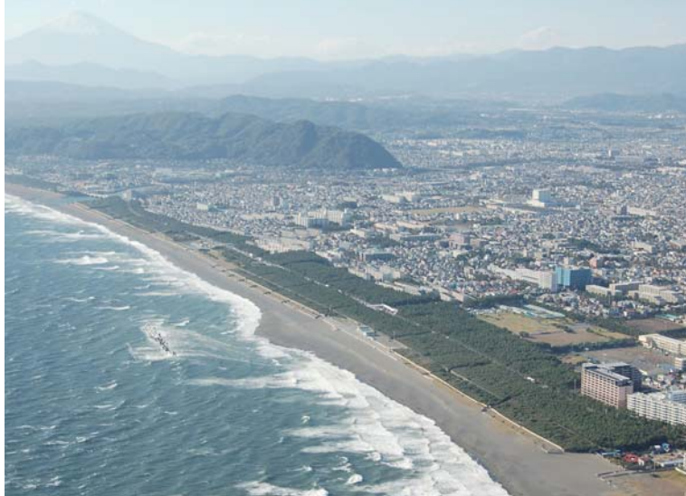
良好に生育した砂防林(相模川河口付近から西方を俯瞰)
